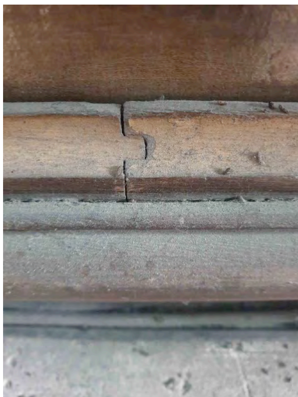
Détail d'un des assemblages à rainure et languette de la partie inférieure de l'encadrement de l'œuvre Jésus au Mont des Oliviers – Chapelle Nord.
