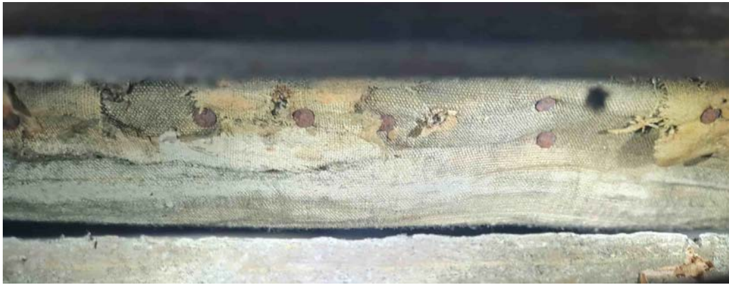
Détail des semences dans le chant du montant inférieur (en bas)
