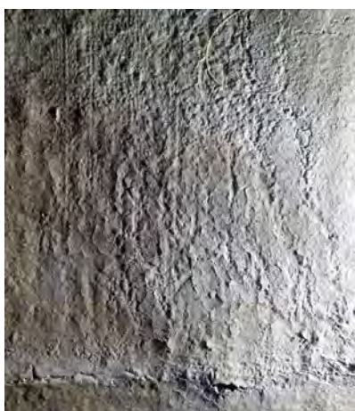
Détail d'une zone craquelée présentant des pertes de matière et soulèvements
