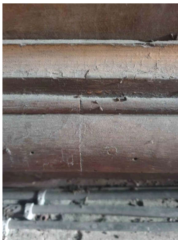
Détail d'un des assemblages à joint vif de la partie supérieure de l'encadrement de l'œuvre Jésus au Mont des Oliviers – Chapelle Nord.
