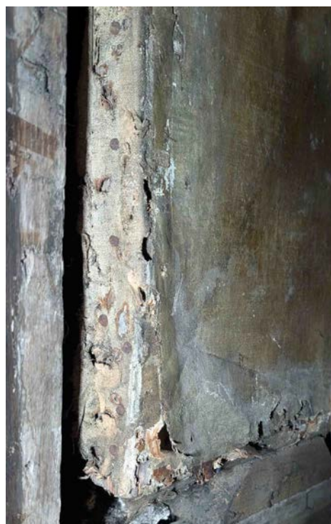
Détail des semences dans le chant du montant dextre (à gauche)
