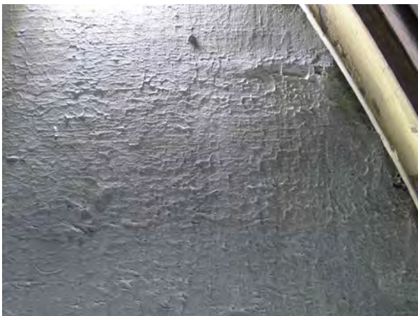
Détail d'une zone craquelée présentant des pertes de matières et soulèvements
