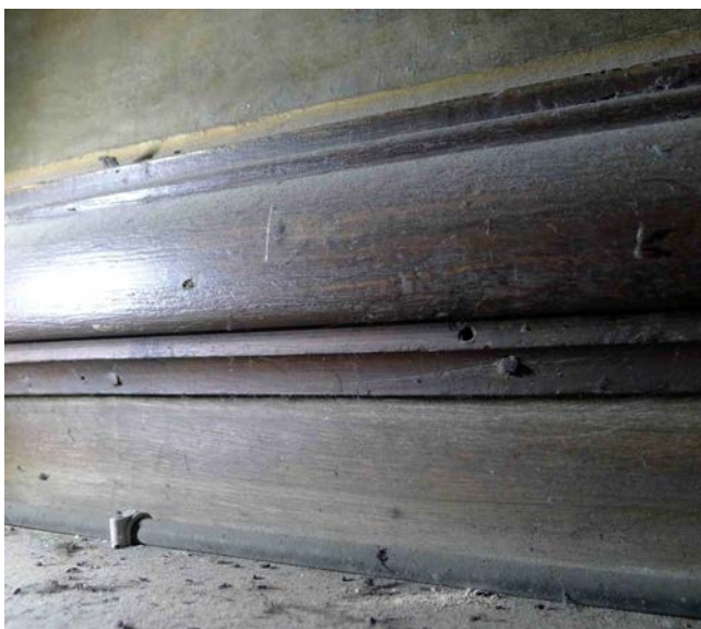
Détails des clous à tête plate maintenant les éléments d'encadrement.
