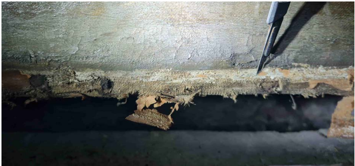
Détail du bord inférieur, avec les semences oxydées et les restes de bordage
