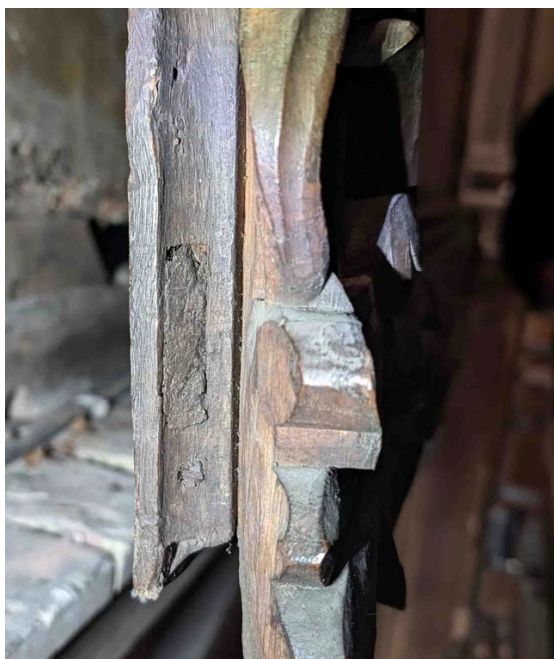
Détail d'un assemblage d'angle des baguettes d'encadrement à tenon et mortaise
