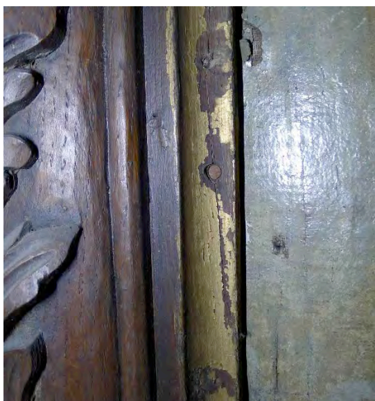
Détails des clous à tête plate maintenant les éléments d'encadrement.
